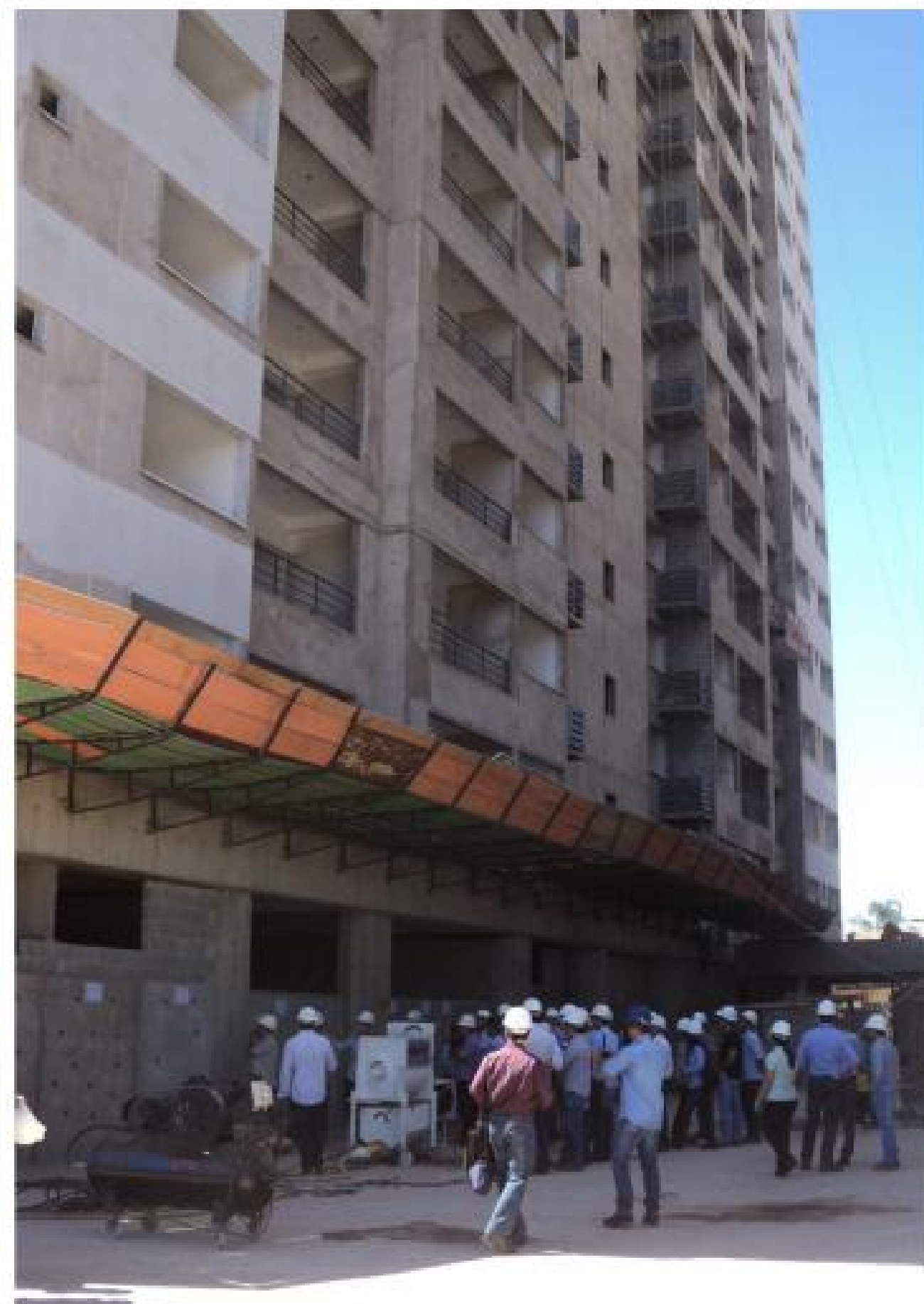
• Etapa prática do minicurso de Revestimento de Argamassa – Canteiro do Terra Mundi – Santos Dumont (10/10/2013)
